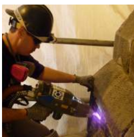
تمیز کاری سنگ با استفاده از لیزر
