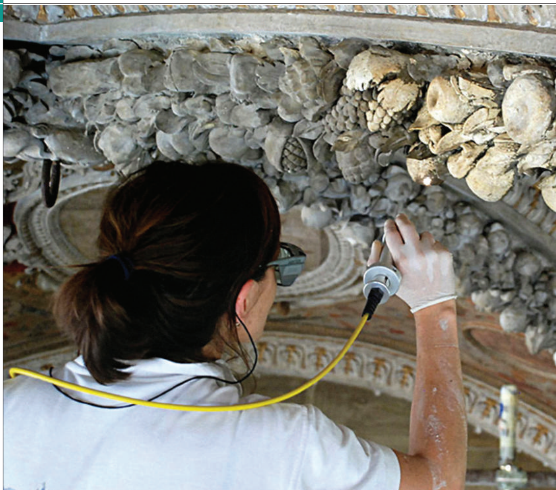
تمیز کاری سنگ با استفاده از لیزر
